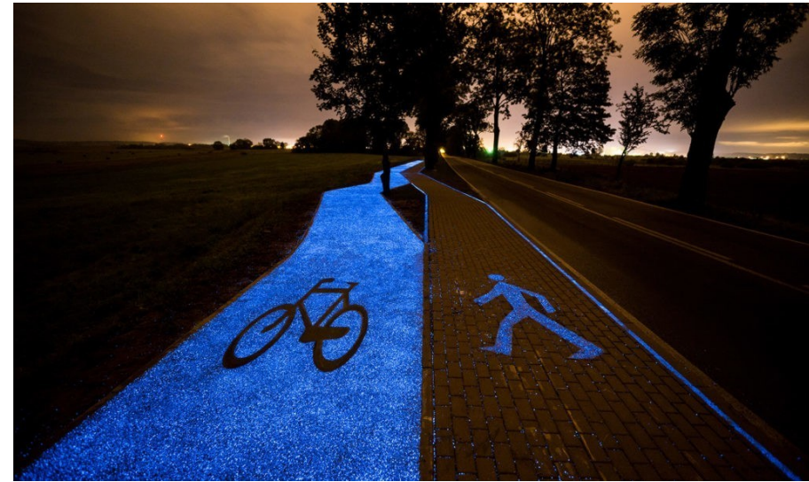
FIGURA 13. Iluminación de Ciclovía y paso peatonal en Polonia. Martínez (2016)
